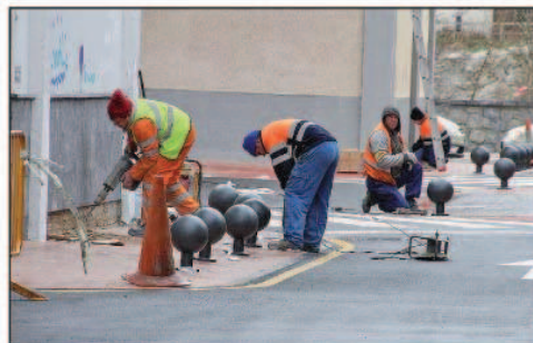
Obreros realizando trabajos de asfaltamiento en una calle de la localidad.
